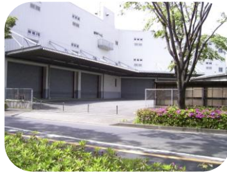
青梅市新町倉庫
