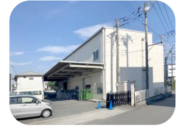
東大和市立野 2丁目倉庫
