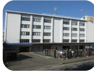
東大和市立野 4丁目倉庫
