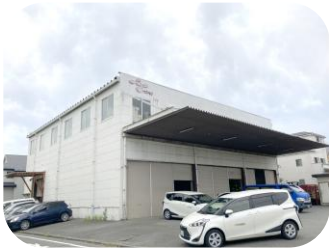
東大和市新堀倉庫
